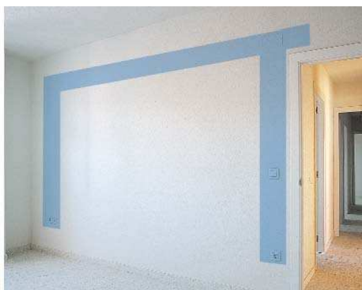
23. Bandas por donde discurren las instalaciones. Cocina. 24. Bandas por donde discurren las instalaciones. Salón.
