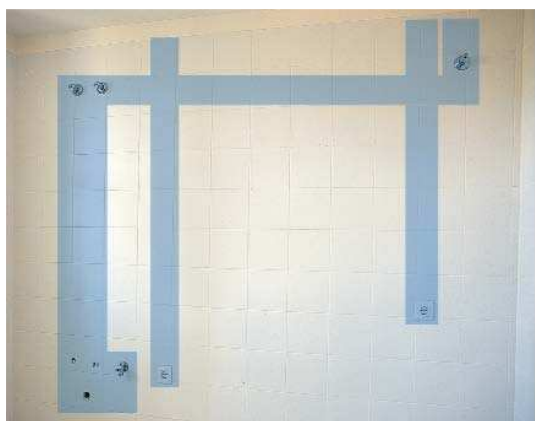
23. Bandas por donde discurren las instalaciones. Cocina. 24. Bandas por donde discurren las instalaciones. Salón.
